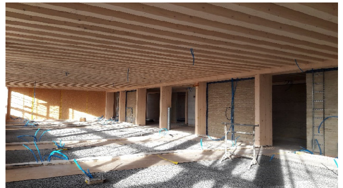
Ecole de Marly en construction avec du bois local
